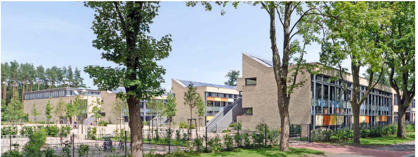
Grundschule Niederheide, Hohen Neuendorf - Ostfassade
