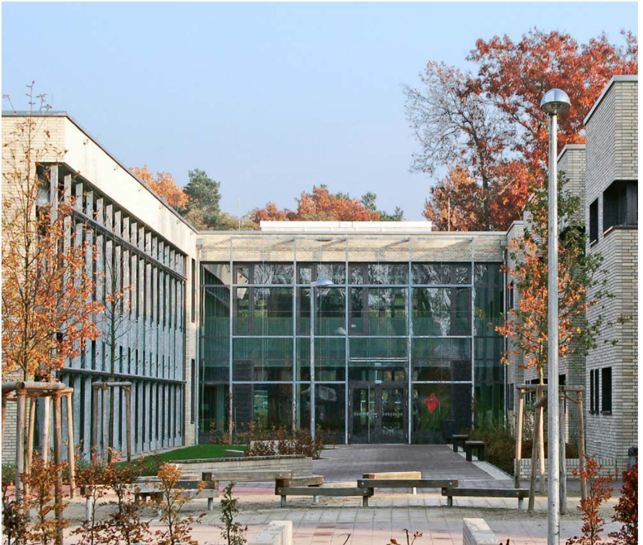
Grundschule Niederheide, Hohen Neuendorf
